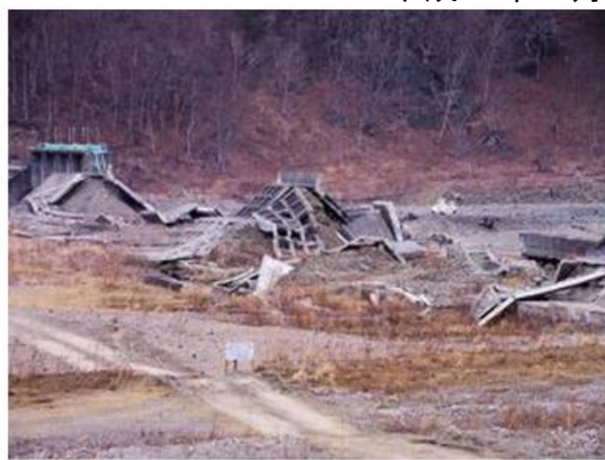
明戸防潮堤跡
